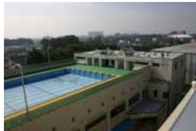
屋上よりプールを望む (P2J)
